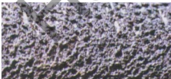
شکل ۱۳: آثار مکانیزم Erosion روی سطح لوله‌ای از جنس فولاد نرم که در مسیر تخلیه توربین قرار گرفته بود [۳].
